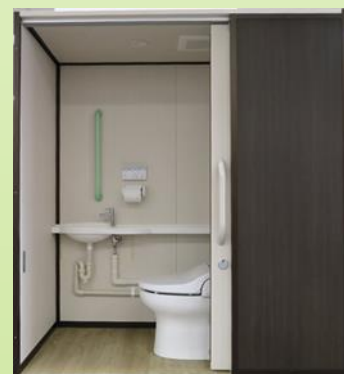
(洋式トイレ・多目的 トイレの設置、改修)
